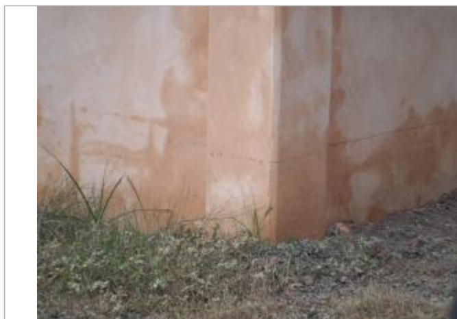
Photo PHE - Auteur : SAFEGE
