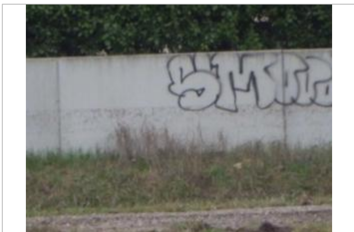
Photo PHE - Auteur : SAFEGE
