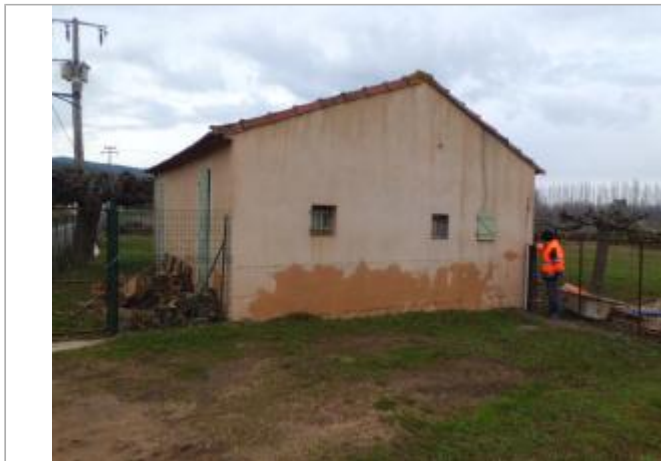
Photo du site - Auteur : SAFEGE
