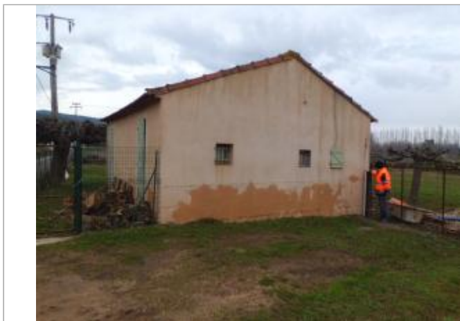
Photo du site - Auteur : SAFEGE
