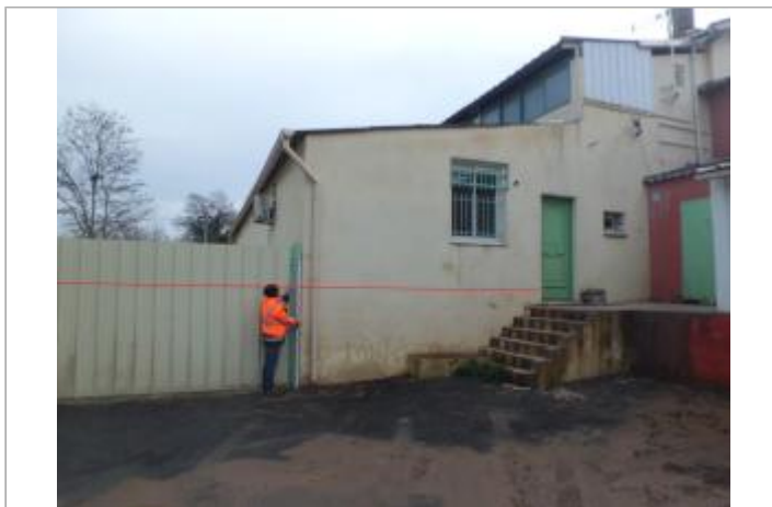
Photo du site - Auteur : SAFEGE
