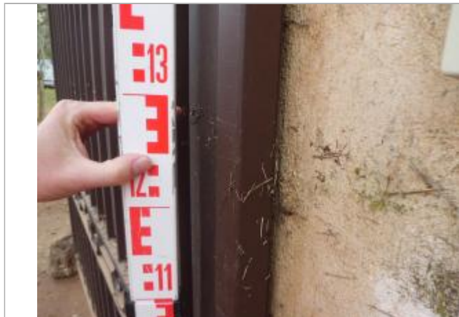
Photo PHE - Auteur : SAFEGE
