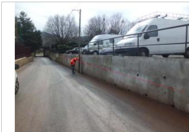
Photo du site - Auteur : SAFEGE
