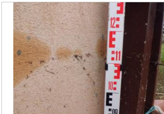
Photo PHE - Auteur : SAFEGE
