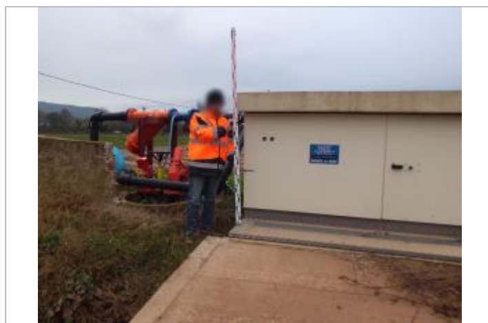
Photo du site - Auteur : SAFEGE
