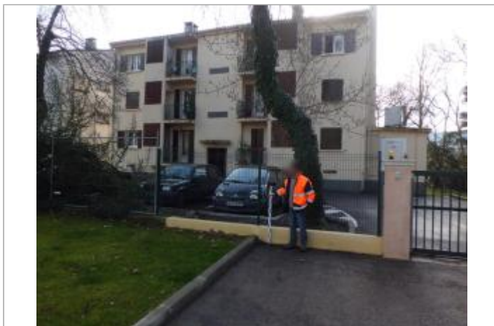
Photo du site - Auteur : SAFEGE
