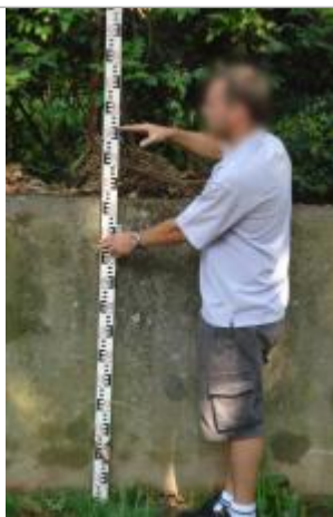
Vue du repère - Auteur : Cerema Méditerranée
