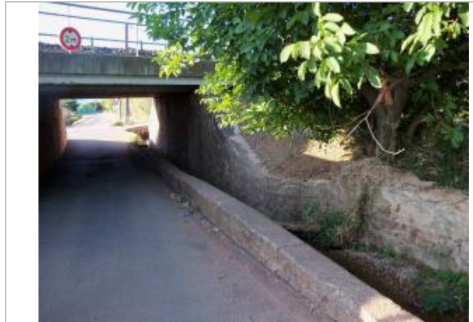
Vue du site - Auteur : Cerema Méditerranée
