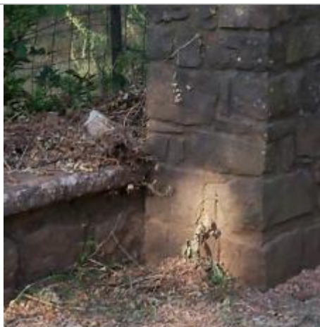
Vue du repère - Auteur : Cerema Méditerranée
