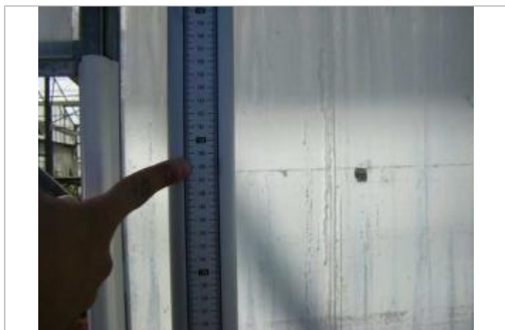
Vue de la PHE - Auteur : EGIS
