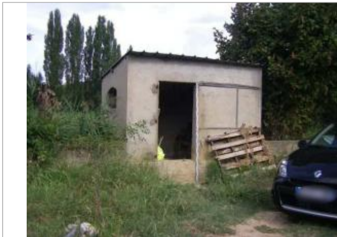
Vue du site - Auteur : EGIS
