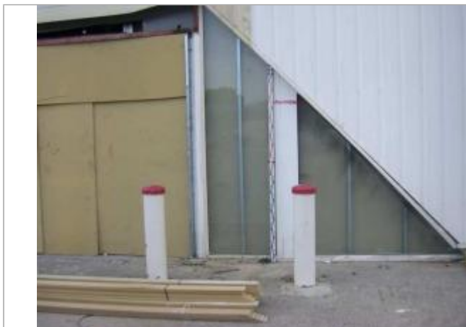
Vue du site - Auteur : EGIS
