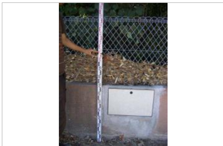
Vue de la PHE - Auteur : EGIS
