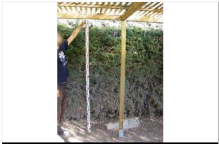
Vue de la PHE - Auteur : EGIS
