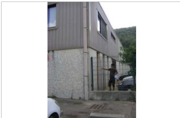
Vue du site - Auteur : EGIS
