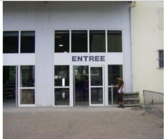
Vue du site - Auteur : EGIS
