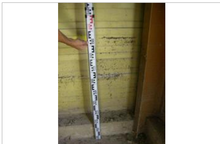
Vue de la PHE - Auteur : EGIS
