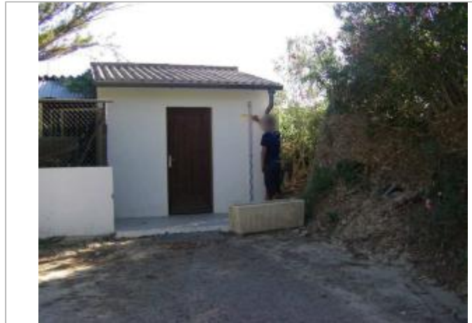
Vue du site - Auteur : EGIS
