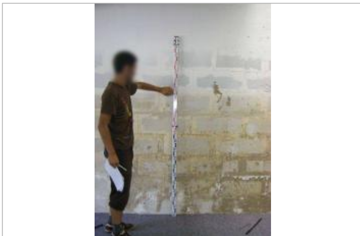
Vue de la PHE - Auteur : EGIS
