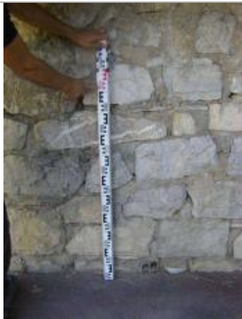
Vue de la PHE - Auteur : EGIS
