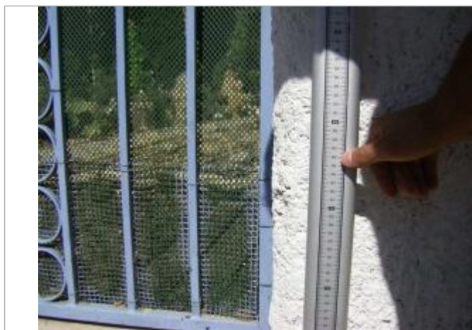
Vue de la PHE - Auteur : EGIS
