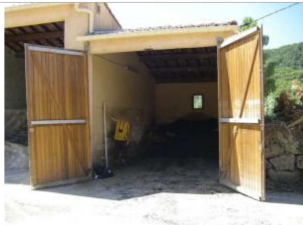
Vue du site - Auteur : EGIS
