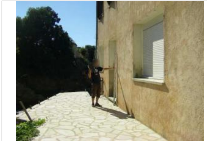
Vue du site - Auteur : EGIS
