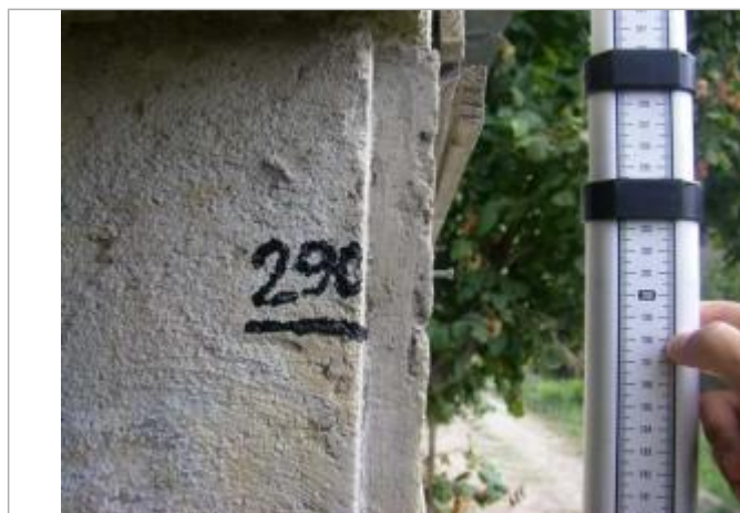
Vue de la PHE - Auteur : EGIS
