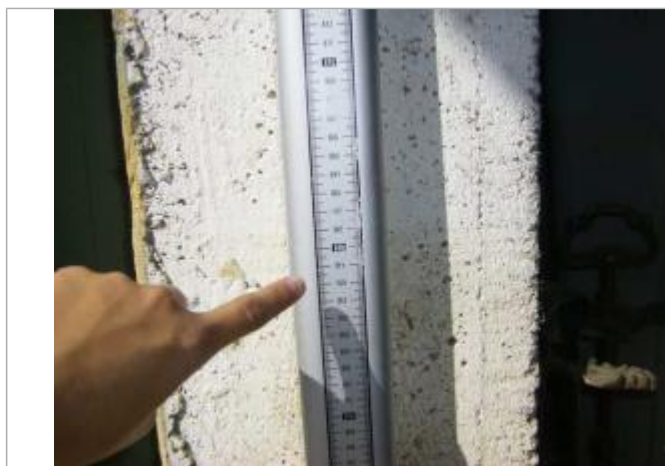
Vue de la PHE - Auteur : EGIS
