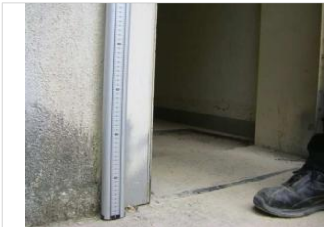
Vue de la PHE - Auteur : EGIS
