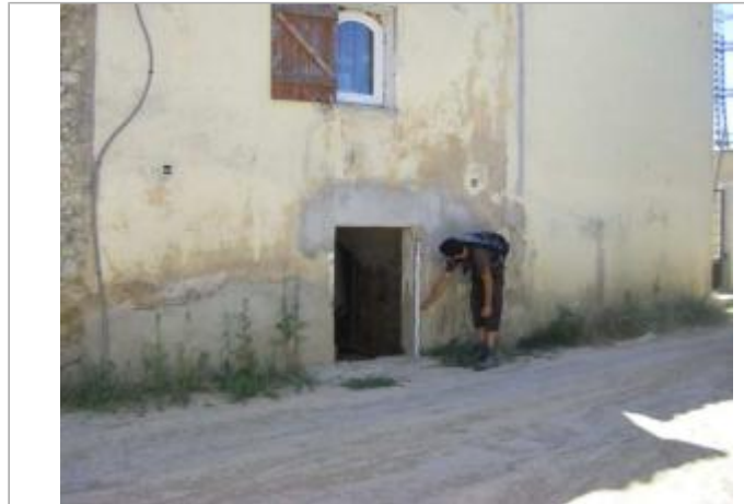
Vue du site - Auteur : EGIS
