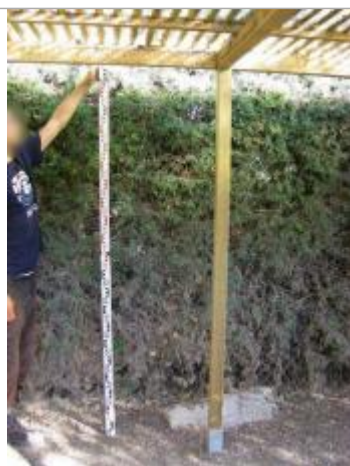
Vue de la PHE - Auteur : EGIS
