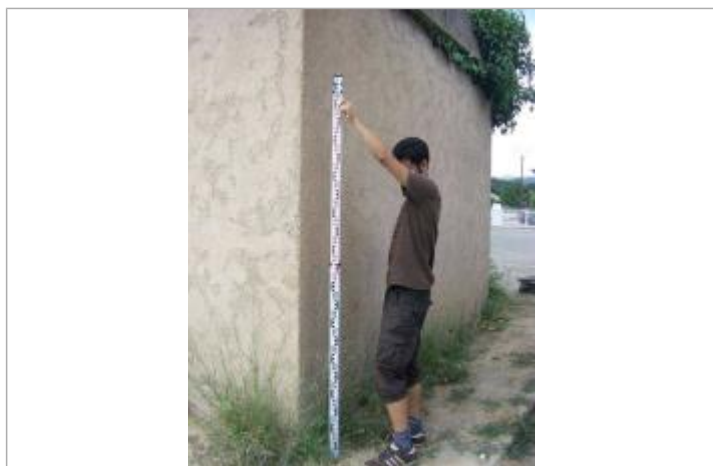
Vue de la PHE - Auteur : EGIS
