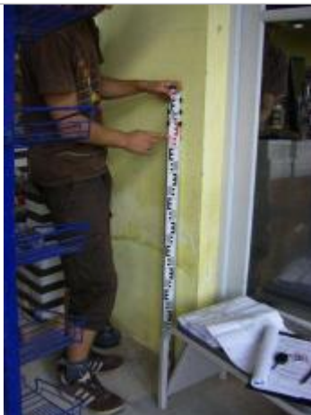
Vue de la PHE - Auteur : EGIS
