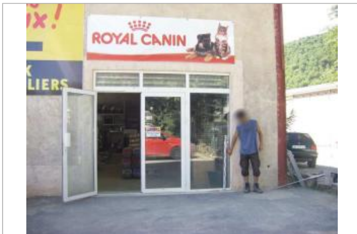
Vue du site - Auteur : EGIS
