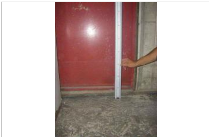
Vue de la PHE - Auteur : EGIS
