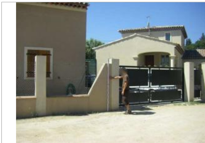
Vue du site - Auteur : EGIS
