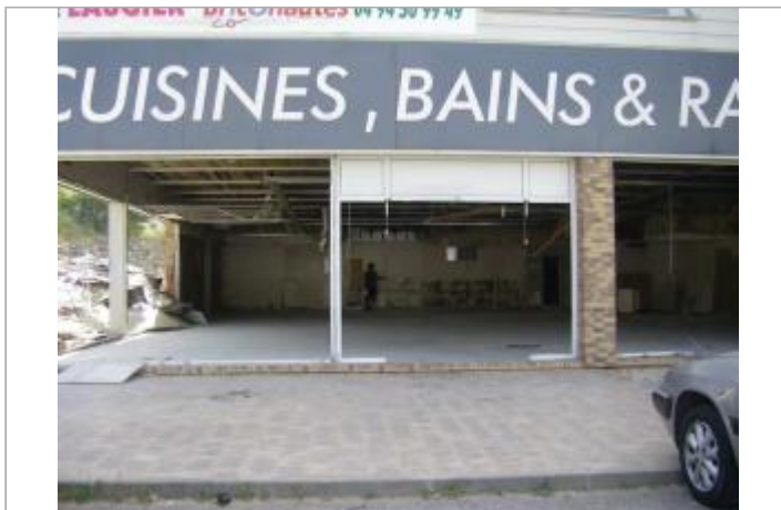
Vue du site - Auteur : EGIS
