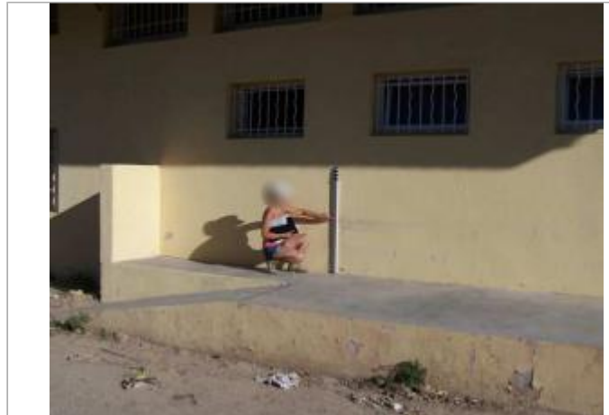
Vue du site - Auteur : EGIS
