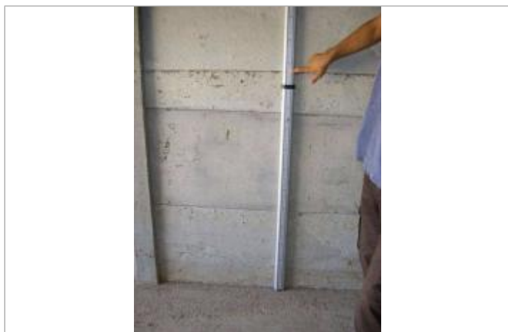
Vue de la PHE - Auteur : EGIS
