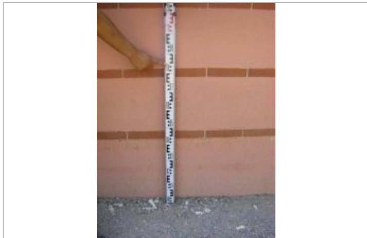
Vue de la PHE - Auteur : EGIS
