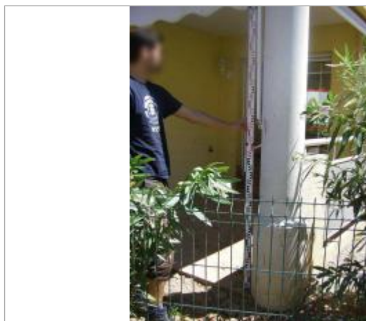
Vue de la PHE - Auteur : EGIS
