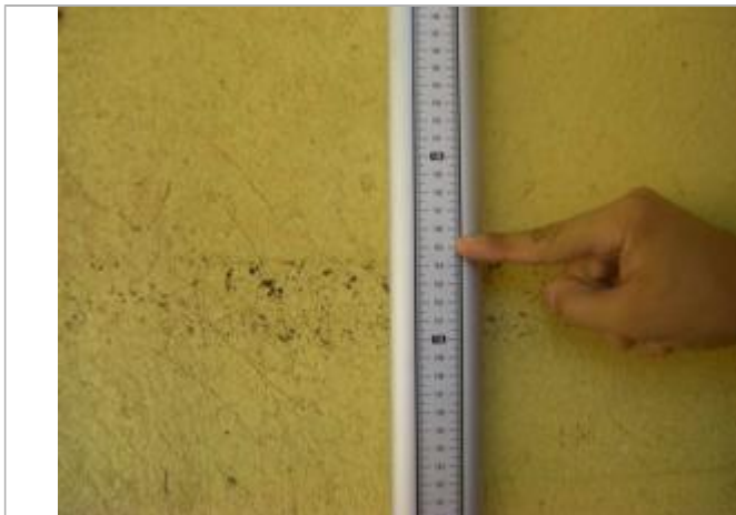
Vue de la PHE - Auteur : EGIS
