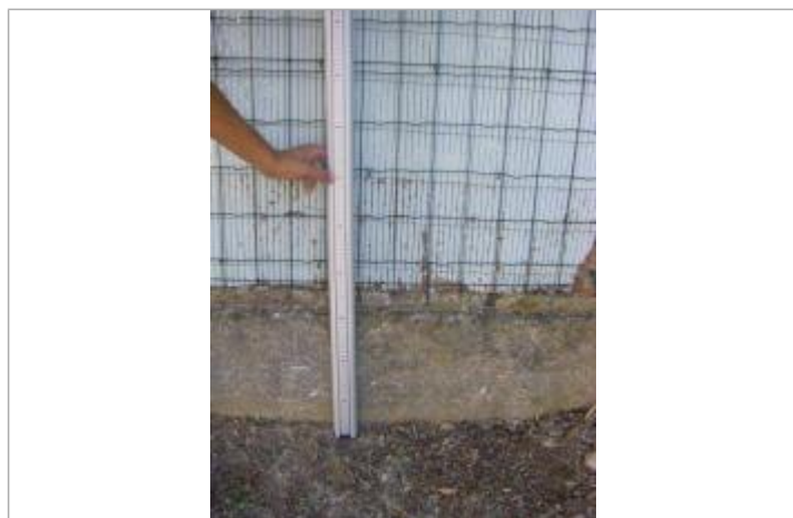
Vue de la PHE - Auteur : EGIS
