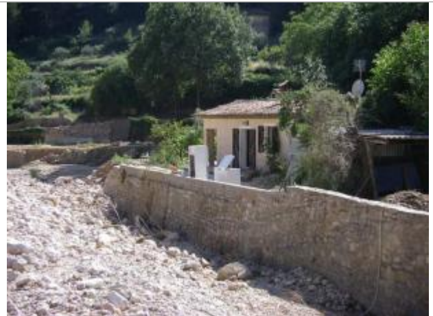
Vue du site - Auteur : EGIS
