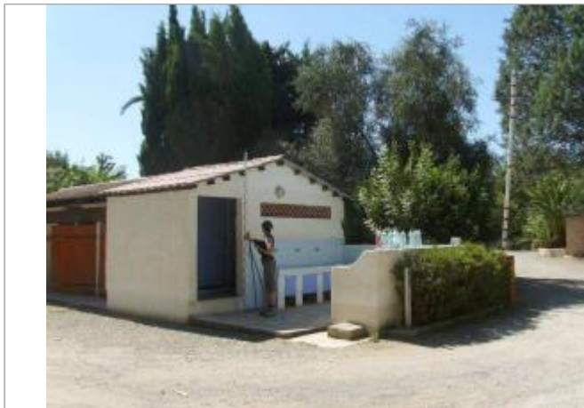
Vue générale - Auteur : EGIS Eau
