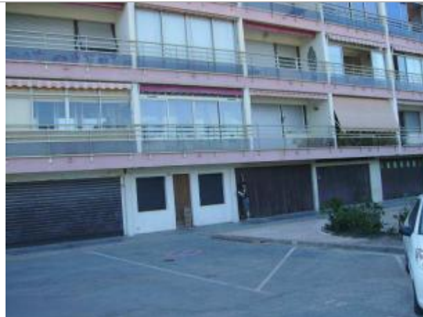
Vue générale - Auteur : EGIS Eau
