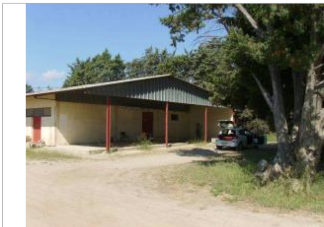
Vue générale - Auteur : EGIS Eau
