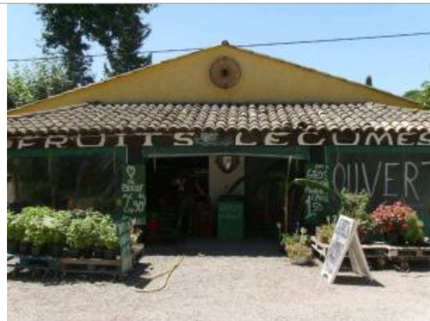
Vue générale - Auteur : EGIS Eau
