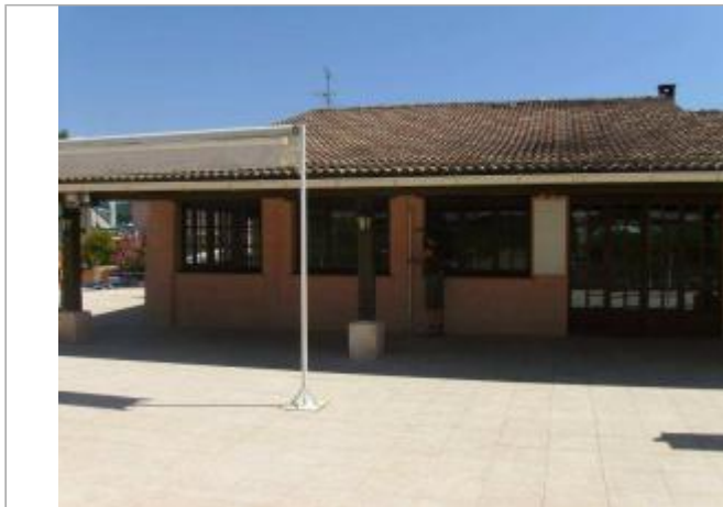
Vue générale - Auteur : EGIS Eau
