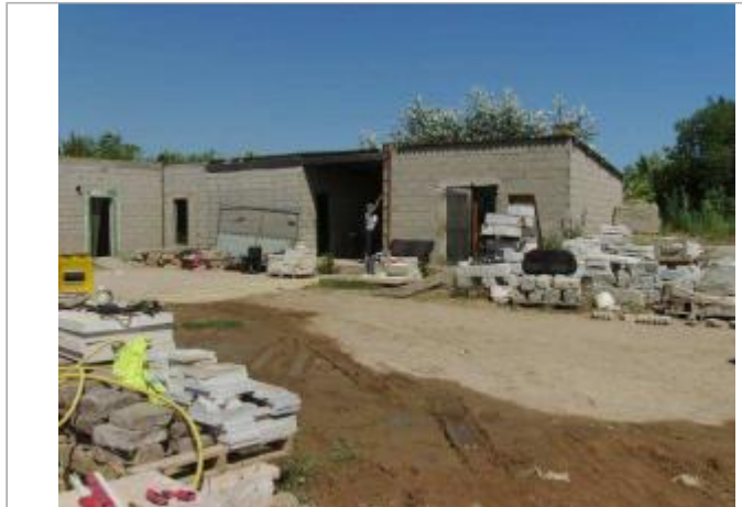
Vue générale - Auteur : EGIS Eau
